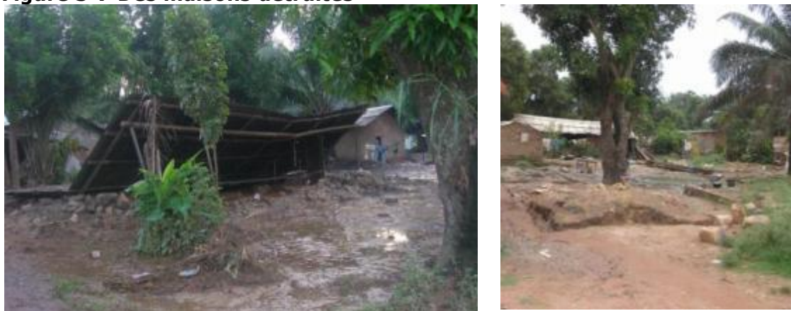
Figure 3-7 Des maisons détruites
