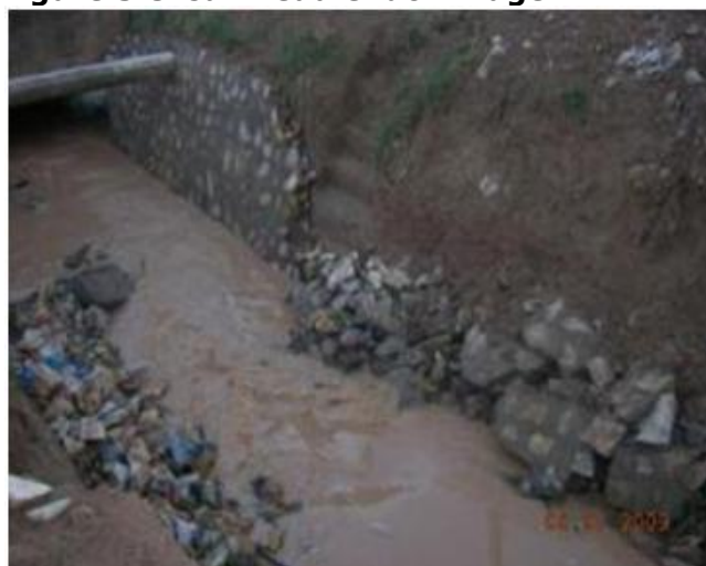
Figure 3-9 Caniveau endommagé
